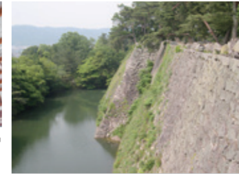
日本有数の高さ誇る高石垣は藤堂高虎が築城した当時のまま。上から覗いても下から見上げても圧巻!
